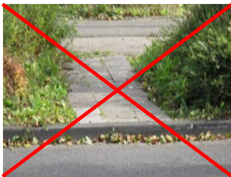
Absenkung über drei Zentimeter
